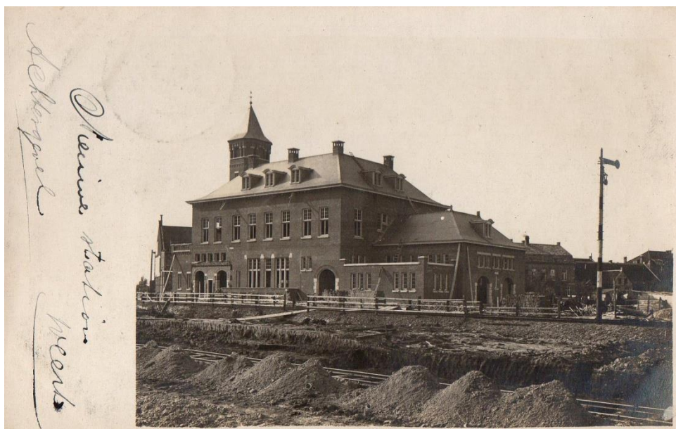
Het stationsgebouw is gereed men is nu bezig met de aanleg van de spoorlijnen en het perron met zijn overkapping. We zien op de prentbriefkaart de achterzijde van het station.
