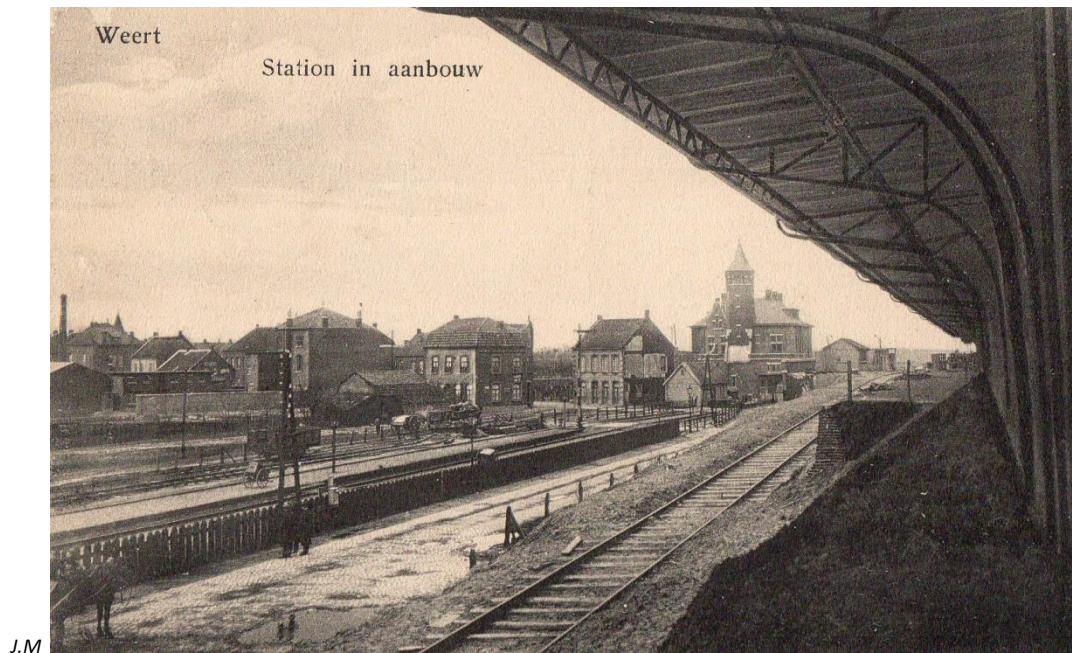
Prentbriefkaart van het station Weert in aanbouw in 1913 – 1914. We zien links het oude laagspoor en midden het hoogspoor in aanbouw. De rails gaat van laag naar hoogspoor. Ter hoogte van het stationsgebouw heeft het spoor al zijn uiteindelijke hoogte bereikt.
