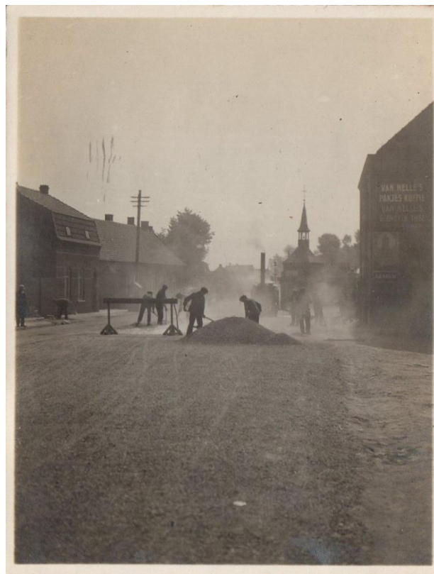
Foto van het opbreken en verwijderen van de tramrails en aanbrengen van een laag asfalt op de Maaspoort in 1936. Op de achtergrond zien we het kapelletje op het einde van de Maaspoort.
