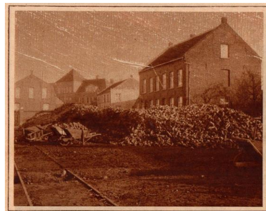
De bietencampagne in Weert is weer in vollen gang. Iederen dag worden per boot en tram wagenladingen vol aangevoerd, waarna het verdere vervoer door schepen plaats vindt. Onze foto laat 'een hoopje' bieten zien, wachtend op verder transport.
